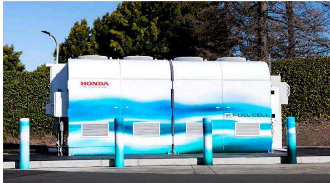
En marzo de 2023, Honda puso en funcionamiento una central eléctrica estacionaria de pila de combustible en sus instalaciones de Torrance (California, EE.UU.), lo que supone el primer paso de la empresa hacia la futura comercialización de energía de reserva con cero emisiones.
