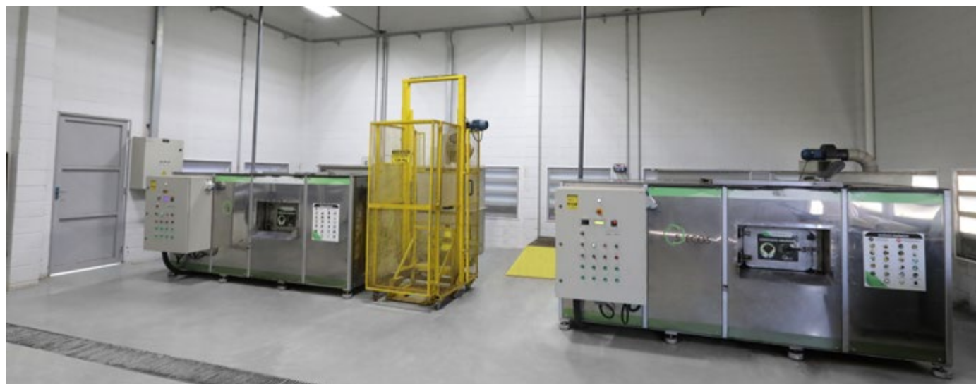
Central de Compostagem Interna da Honda Automóveis em Sumaré (SP).
